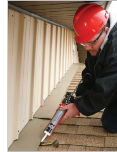
Étanchéité sous les solins métalliques
