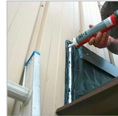
Étanchéité des barres de terminaison
