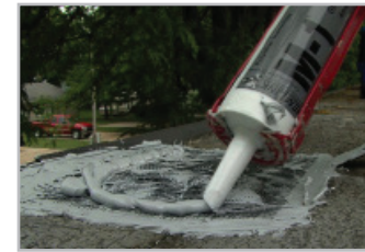
Réparation d'une fuite au solin
